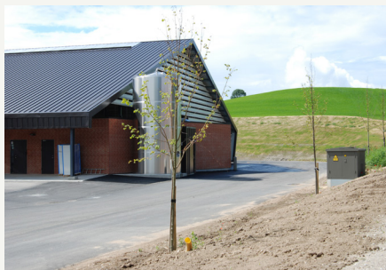
Her ses gode befæstede udearealer. Den rustfrie køletank til opbevaring af mælk, er placeret strategisk godt, så den store tankvogn nemt kan manøvrere.
